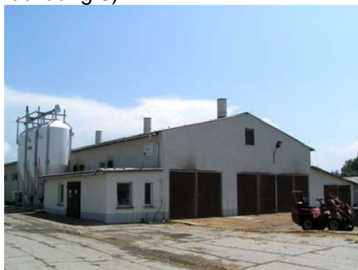
Abbildung 6: Außenansicht Betrieb C
