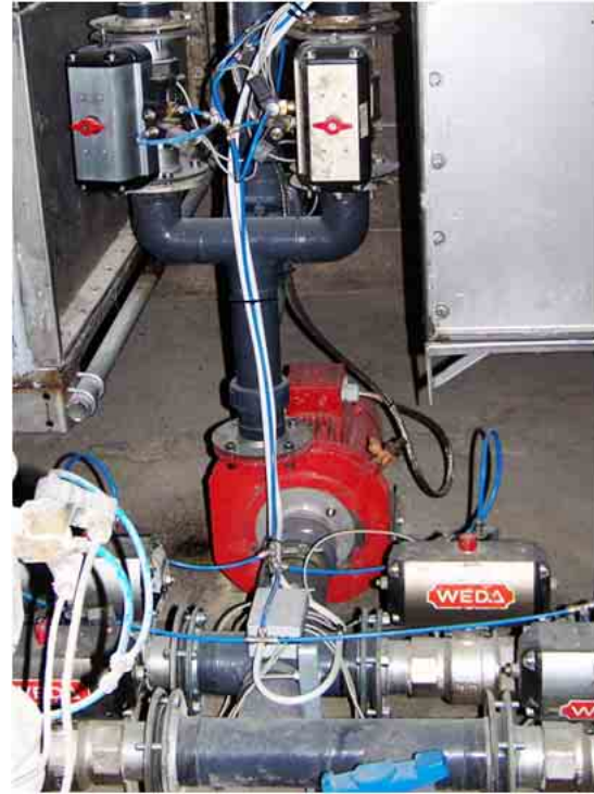
Abbildung 14: Ansicht Fermenter sowie Leitungs- und Steuerungseinheit für Fermenterbewirtschaftung
