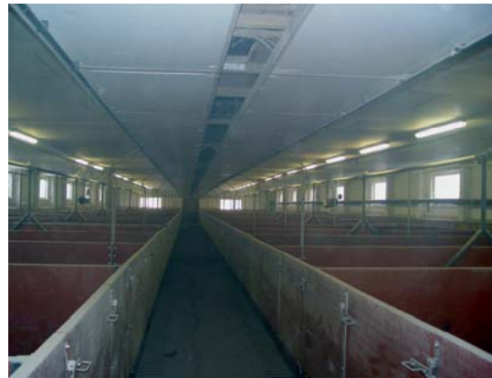
Bild 2: rekonstruierter Stall Betrieb K
