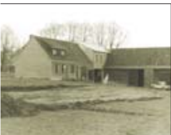
Ausbau des Hofes 1986
