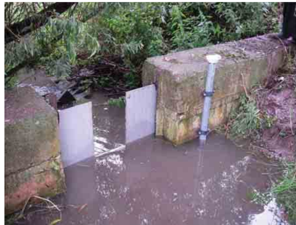
Abb. 8: Wehr und Rohr mit Pegel im Bennebach.
