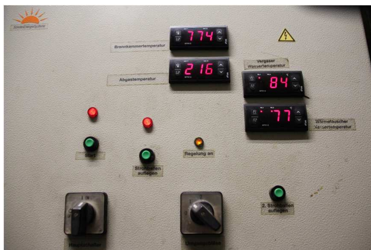
Schaltschrank mit Temperaturanzeigen und Regelgrößen
