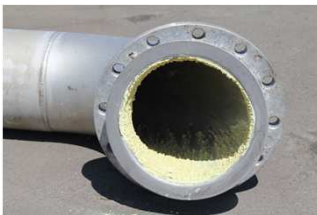
Wirkung BiogasPrimer bei optimalen Einsatz
