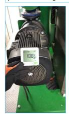
Betr.: BGA BHKW 500 kW\_e 7,5 kW Kühlkreispumpe benötigt leider 11 kW
