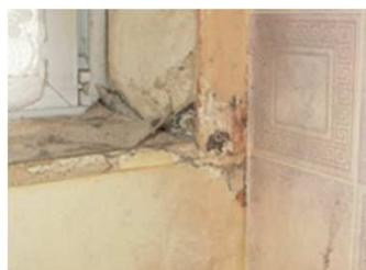
Abb.2 Schimmelpilzbefall der Gipskartonlage nach Abnahme der Fliesentapete in und um die Bereiche der Fensterleibungen (DFWZ QLB)
