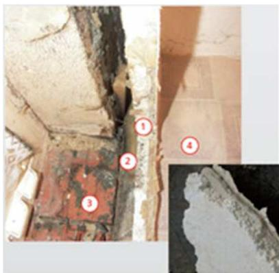
Abb1 Wandaufbau in der Untersicht des Fenstersturzes: 1 Styropor-Verbundplatte aus 1,25 cm Gipsfaser und 1,5 cm Styropor auf 2 Holzleisten, Luftzwischenraum, 3 Hochlochziegel, innen folienbespannte Fliesentapete (DFWZ QLB)
